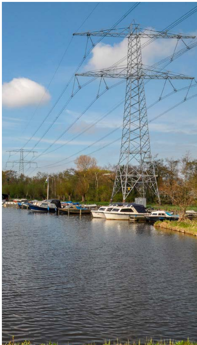
De hoogspanningsleiding doorsnijdt de Kogerveldwijk
