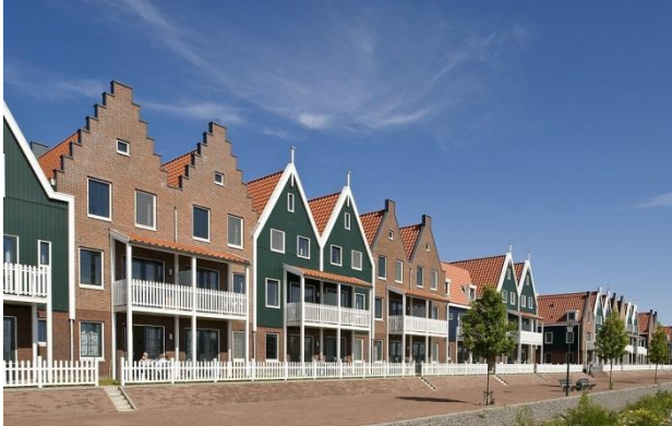
Kleinschalige woonbebouwing op de dijk, Nieuwbouw Marina, Volendam
