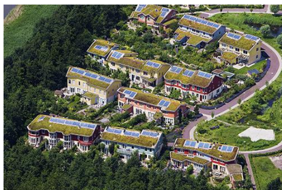
Combinatie van mos sedumdaken en zonnepanelen, De buitenkans, Almere
