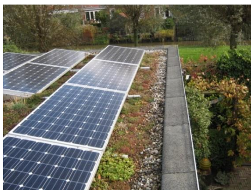
Combinatie van mos sedumdak en zonnepanelen
