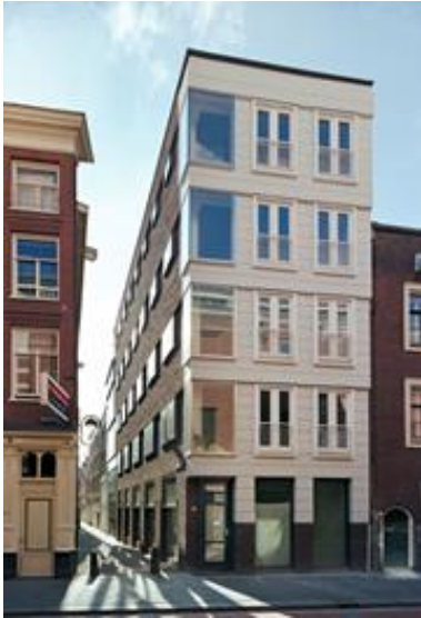
Markante kop van bouwblok, Blauwakenblok, Amsterdam
