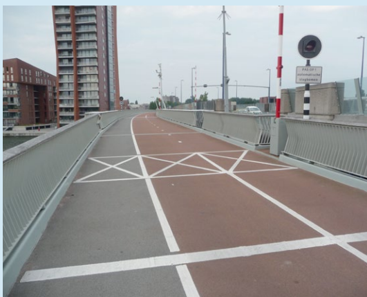
Foto 4: Eerste slagboom en landverkeerssein.
