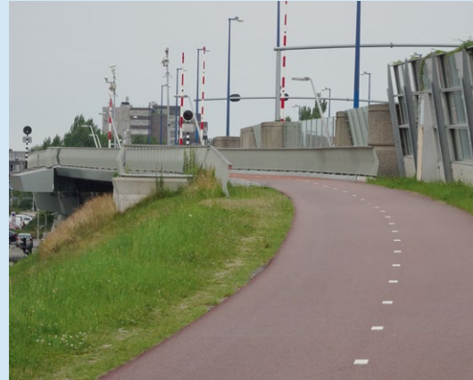
Foto 2: Fietspad naar brug vanuit westen.
