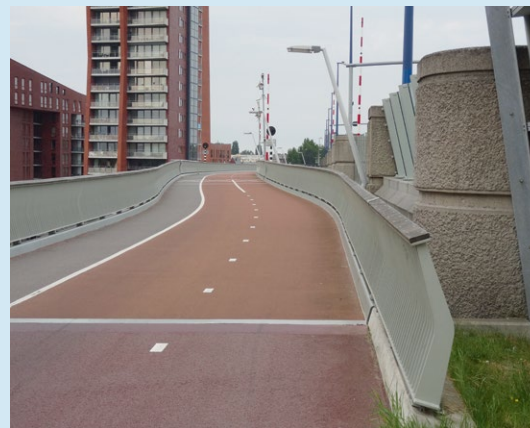
Foto 3: Begin brug westkant.
