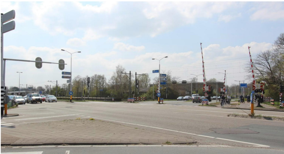
Figuur S.1 Kruising Guisweg-Provincialeweg en spoorovergang Guisweg
