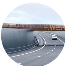
Afwerking slootaquaduct met natuurlijk materiaal (hout) Bron: https://www.omropfryslan.nl/nieuws/950499-nieuwe-tunnel-geopend-de-n381-bij-t-west-naast-donkerbroek
