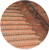
Trap integreren met tunnelbak Bron: https://www.bouwwereld.nl/bouwfouten/stenen-trap/
