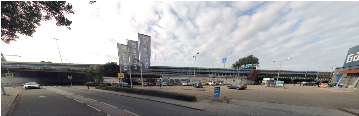
Aanzicht noordzijde snelweg vanuit Koog aan de Zaan bij afslag 2: snelweg op kolommen en dicht scherm. (bron: cyclomedia)
