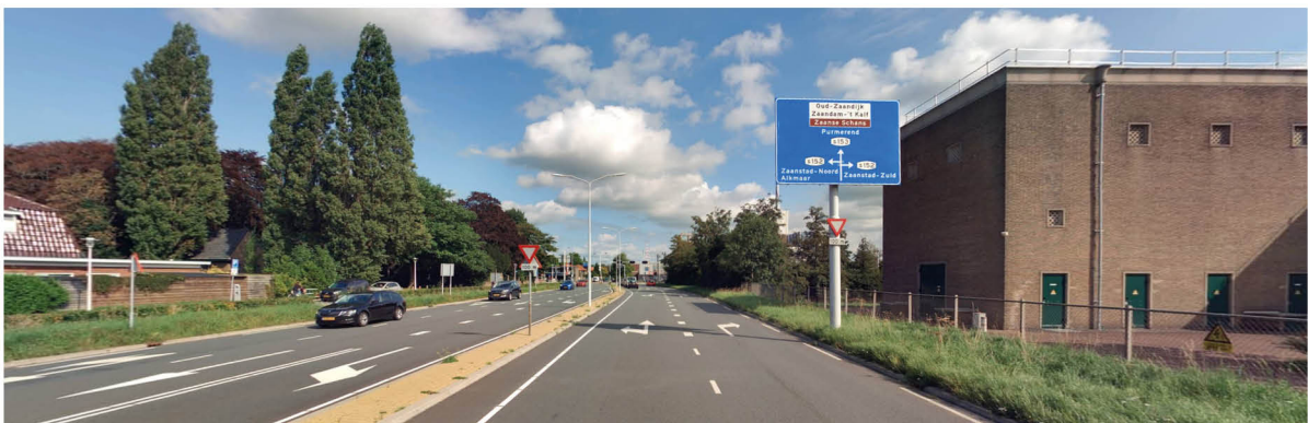
Profiel Guisweg bij spoorwegovergang: het kruispunt bij het spoor kenmerkt zich door het groen van de oude begraafplaats aan de noordzijde, en het transformatorgebouw en wat oude loodsen aan de zuidzijde. De Provincialeweg vormt een harde doorsnijding en is dominant. (bron: cyclomedia)
