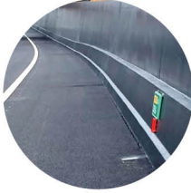
Integratie barri r Bron: https://www.omropfryslan.nl/nieuws/950499-nieuwe-tunnel-geopend-de-n381-bij-t-west-naast-donkerbroek
