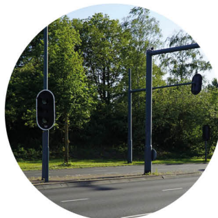
toepassing van donkere kleuren lichtmasten en verkeersregelininstallaties
