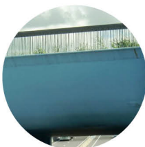
Eigen balustrade slootaquaduct met verwijzing naar het landschap Bron: https://structurae.net/de/bauwerke/aquaduct-de-geeuw
