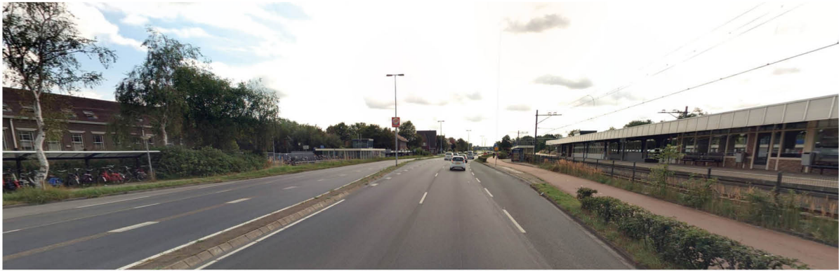
Profiel Provincialeweg bij statio: tussen het spoor en het fietspad staat een hek in een smalle groenstrook. Het fietspad wordt van de Provinciale weg gescheiden door een groenstrook waarin een haag staat, onderbroken door een bushalte. Tussen de beide weghelften ligt een verhoogde middenstrook van ca 0.50m breed. Huizen en fietsenstallingen aan de andere zijde van en Provincialeweg zijn met een groenstrook gescheiden. Daarachter ligt een voetpad. Bij de Cacao-fabriek van Olam is alleen een voetpad aanwezig. (bron: cyclomedia)
