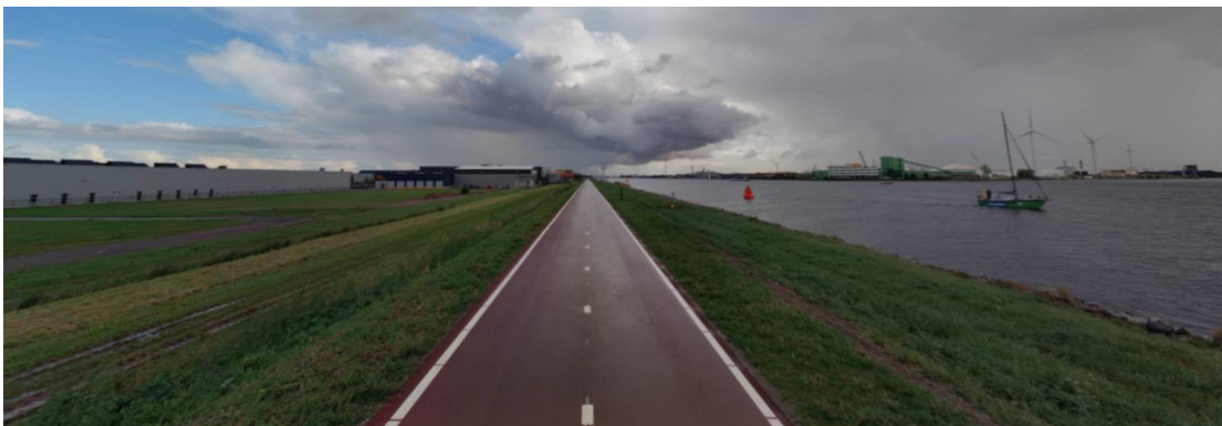
Figuur 3.15 Kanaaldijk, Westzaner Overtoom, kijkend in oostelijke richting
